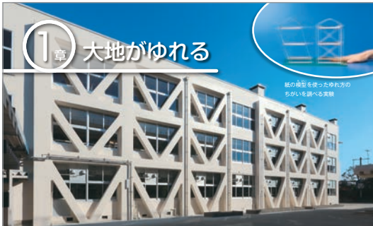
壁づくりに耐震補強がされた校舎 (広島県広島市)
